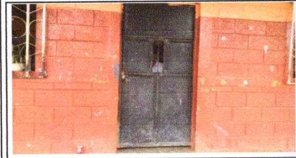
FOTO 5: Mantenimiento a estructura (lijado, cambio de tubo , cepillado, sujeciones, aplicación de pintura) Y Sustitución de chapa
