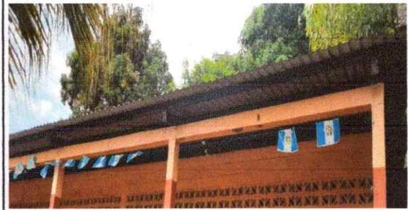
FOTO 8: Sustitución de canal de metal
